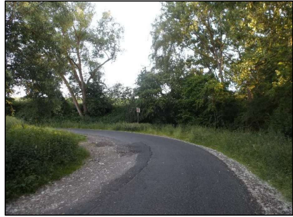
Abb. 13: Mertzwillerstraße im Norden. Bereich der vorgesehenen Zufahrt zum geplanten Wohngebiet
