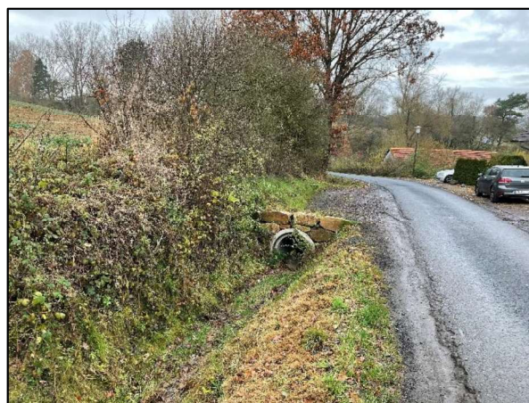
Abb. 6: Ein Teilabschnitt des nördlich verlaufenden Grabens ist verrohrt und mit einer Schotterfläche versehen.
