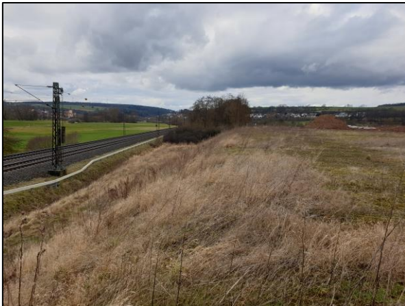
Abb. 7: Südwestlicher Böschungsbereich und angrenzende Bahntrasse
