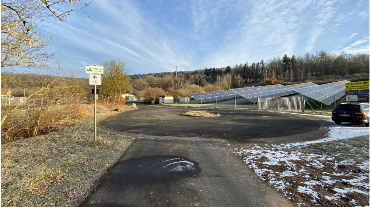
Blick nach Norden in den Wendehammer im GE „In der Breit“
